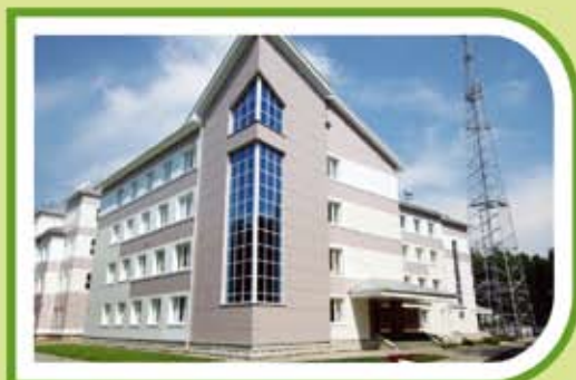
Медико-санитарная часть ООО «Газпром трансгаз Уфа», г. Уфа
